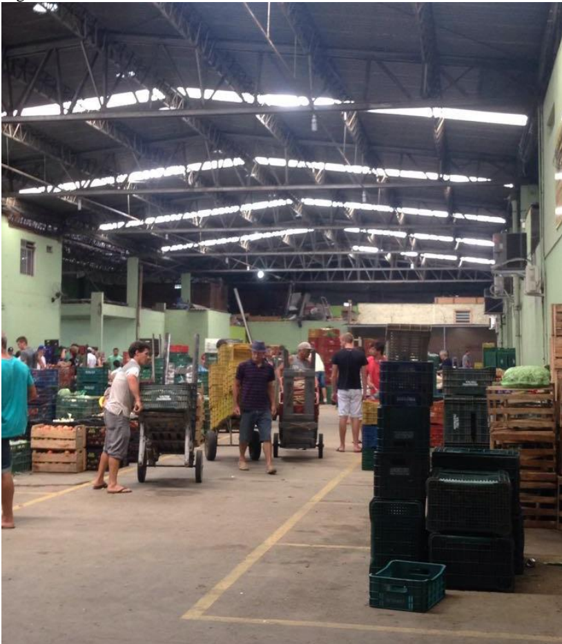
Figura 14 – Pavilhão “A” da CEASA/São José.
