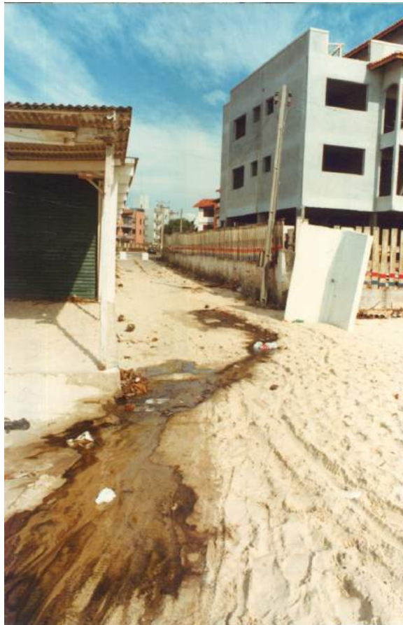
FIGURA 18: Praia de Ingleses – Edificações e esgoto sobre as areias da praia.
