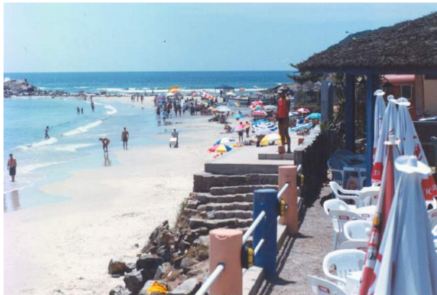
FIGURA 48: Edificações sobre as areias de Armação do Pântano do Sul.
